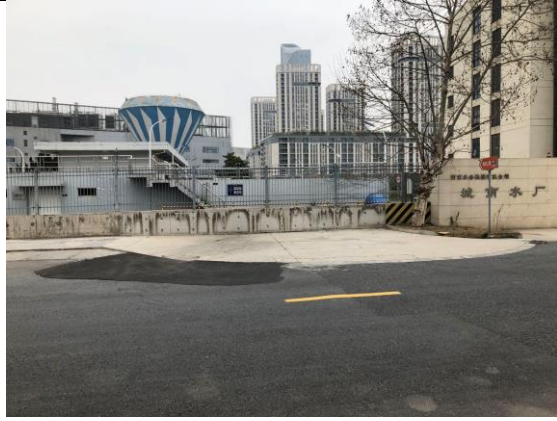
东北侧隔友谊路 城南水厂
