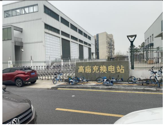
东北侧隔友谊路 高庙充换电站
